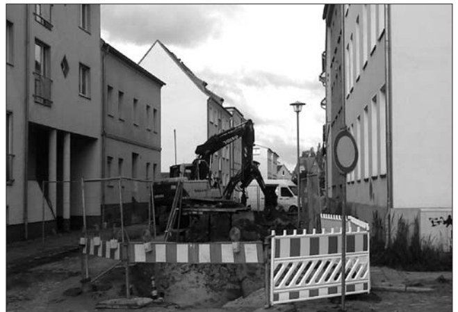
Vorbereitungen für die Einbindung der Gasversorgung und Trinkwasser
