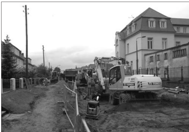
Kanalbauarbeiten in der Schwaaner Straße
