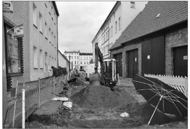
Verlegung der Gas-Hausanschlüsse in der Steinstraße
